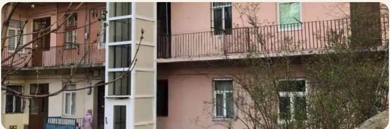
Рисунок 1.33. Приклад прибудови ліфта до галерейного будинку
